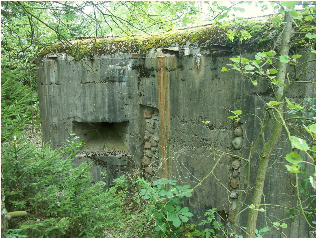
Wygląd schronu 68-HM-01 przed rozpoczęciem renowacji. Widoczne zamurowanie wejścia wykonane w 1953 r. przez żołnierzy LWP. Fot. M. Kozdrój
