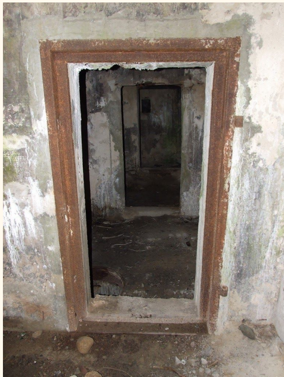
Niemiecka framuga drzwi wewnętrznych, zamontowana wtórnie przez LWP w 1953 r. Zdjęcie wykonano w bliźniaczym schronie na terenie PO Chmielówka. Fot. M. Świtalski
