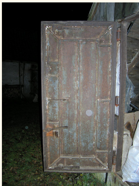
Innego typu drzwi wewnętrzne pochodzące ze schronu bojowego, zamontowane w szopie. Fot. J. Kulak
