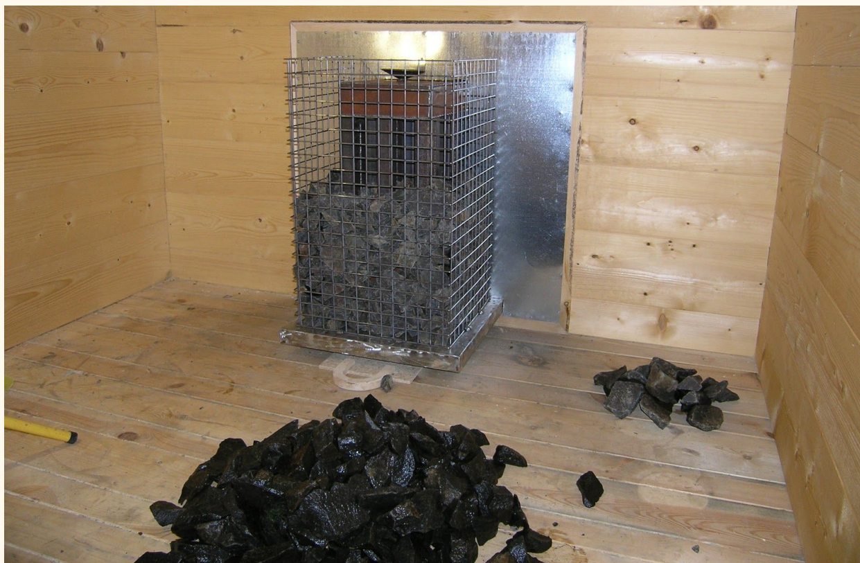
Bazalt używany do budowy schronów, pozyskany w miejscu gdzie stała kruszarka kamieni, współcześnie użyty do wykonania obmurówki pieca w saunie. Fot. J. Kułak
