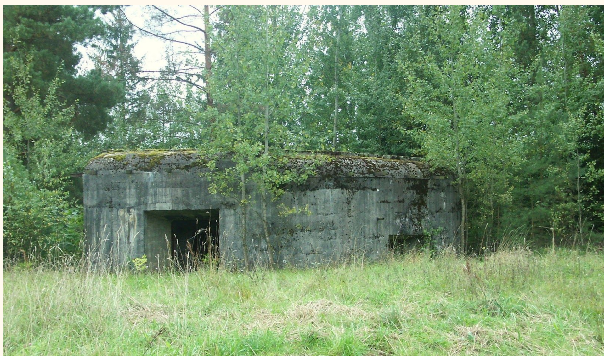
Schron 68-HM-01 przed rozpoczęciem renowacji. Fot. M. Kozdrój
