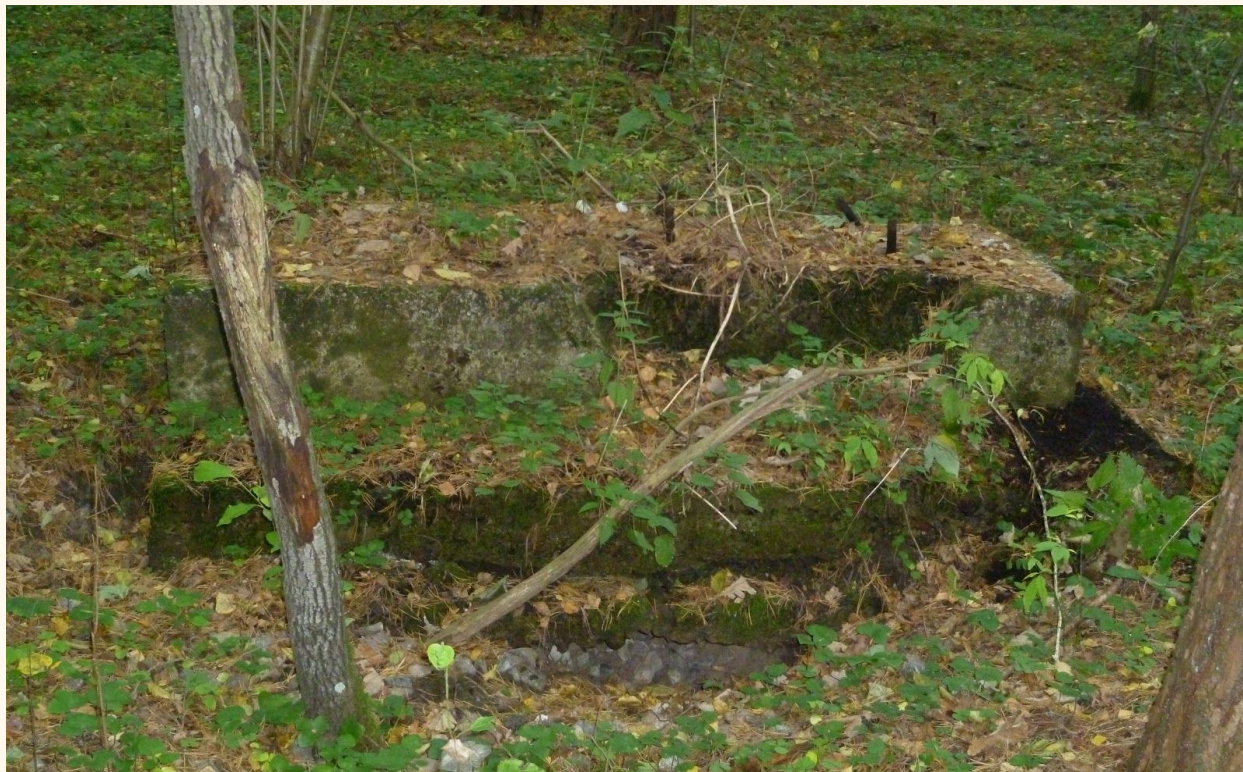
Fundament generatora prądotwórczego zasilającego stolarnię i zbrojarnię. Fot. J. Kułak
