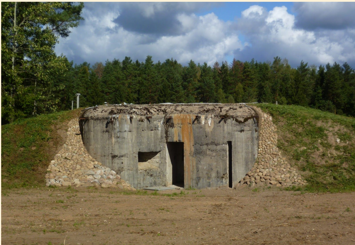
Realizacja zabezpieczenia nasypu ziemnego przed erozją. Fot. J.Kulak
