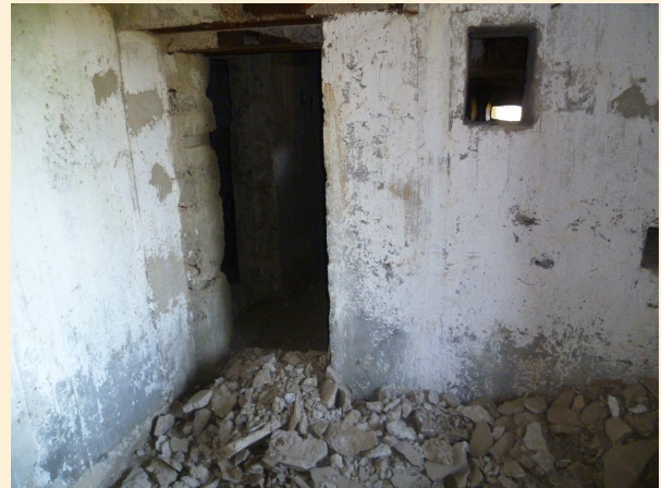
Gruz po usunięciu wtórnych wylewek wykonanych przez LWP. Fot. J. Kulak
