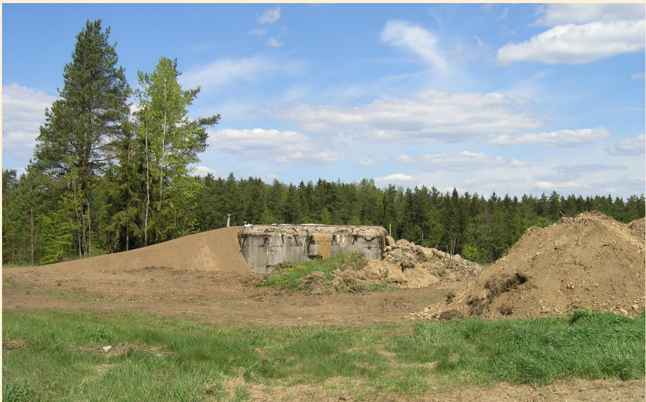
Hałdy ziemi, gruzu i kamieni w czasie prac porządkujących otoczenie schronu. Fot. J.Kulak
