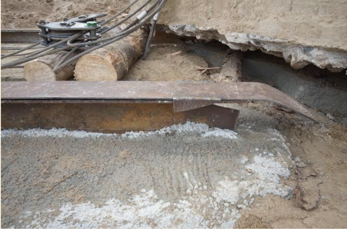
Przesuwne płozy na szynie, osadzonej w betonowej wylewce. Fot. P. Tymiński
