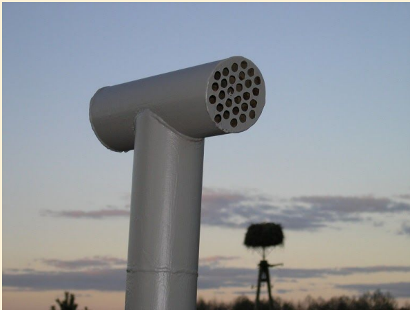
Rura wyrzutu zużytego powietrza z wnętrza schronu odtworzona na podstawie zdjęć archiwalnych. Fot. J.Kułak
