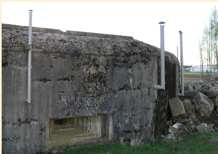
Odtworzone elementy wyposażenia zewnętrznego. Fot. J.Kułak
