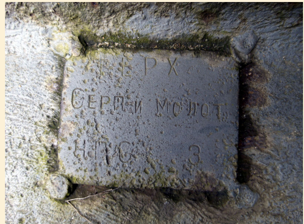
“Sierp i Młot” - oznakowanie montażowe górnej części panczerza NPS-3 wskazujące poprawny kierunek montażu. Po zabetonowaniu panczerza oznaczenie było przykryte betonem. Fot. P.Tymiński
