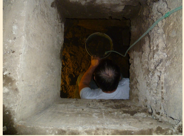
Oczyszczanie zbiornika zrzutni tusek. Fot. J.Kułak
