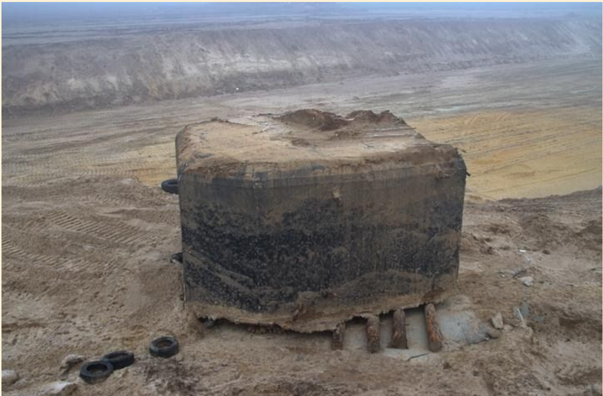
Schron obserwacyjny 64-JK-02 – faza wyjściowa. Fot. P. Tymiąński
