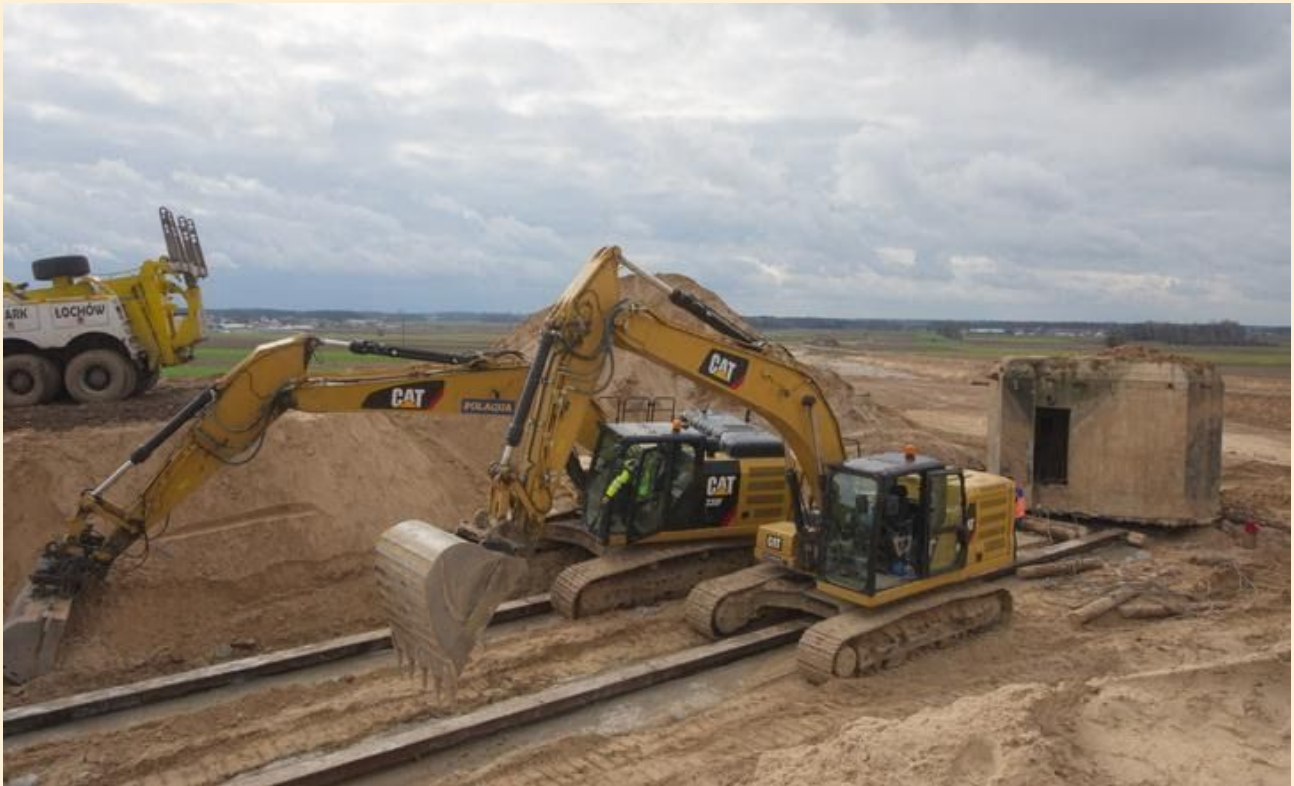
Koparki gąsienicowe CAT – „kotwice” dla schronu w wykopie. Z lewej widoczny jeden z holowników drogowych. Fot. P. Tymiński
