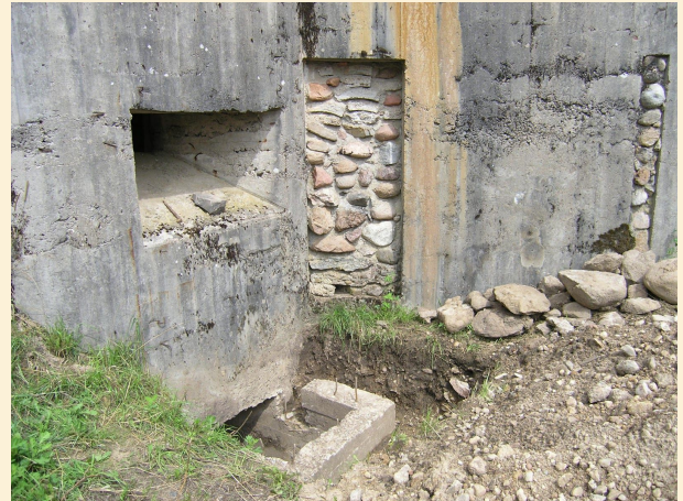
Wyjście ewakuacyjne po odkopaniu. Fot. J.Kulak
