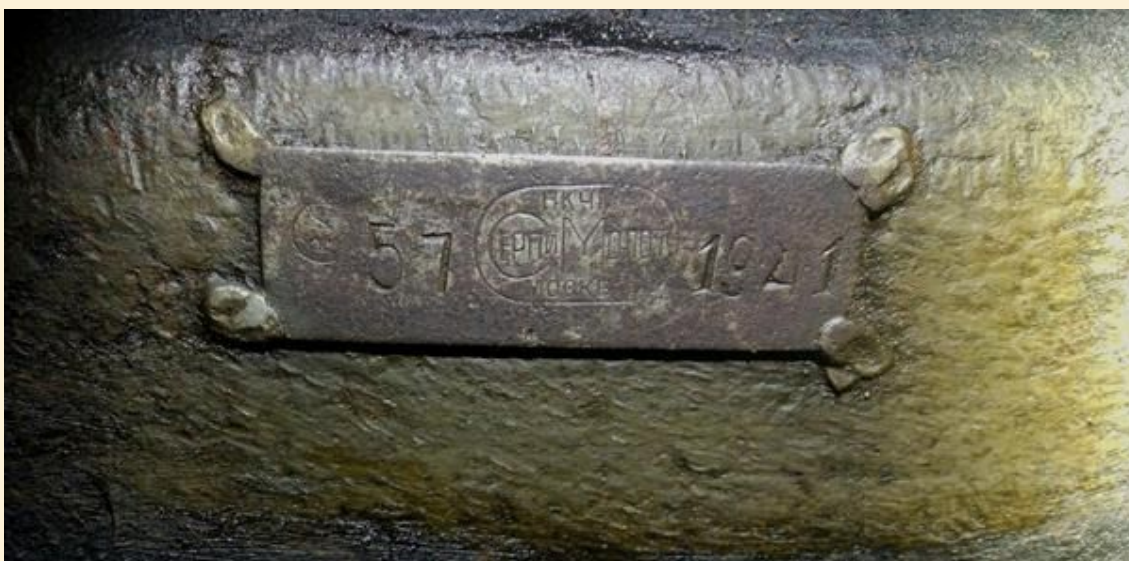
"Sierp i Młot" - standardowa tabliczka znamionowa pancerza NPS-3 wyprodukowanego w 1941 r. Fot. M. Kozdrój
