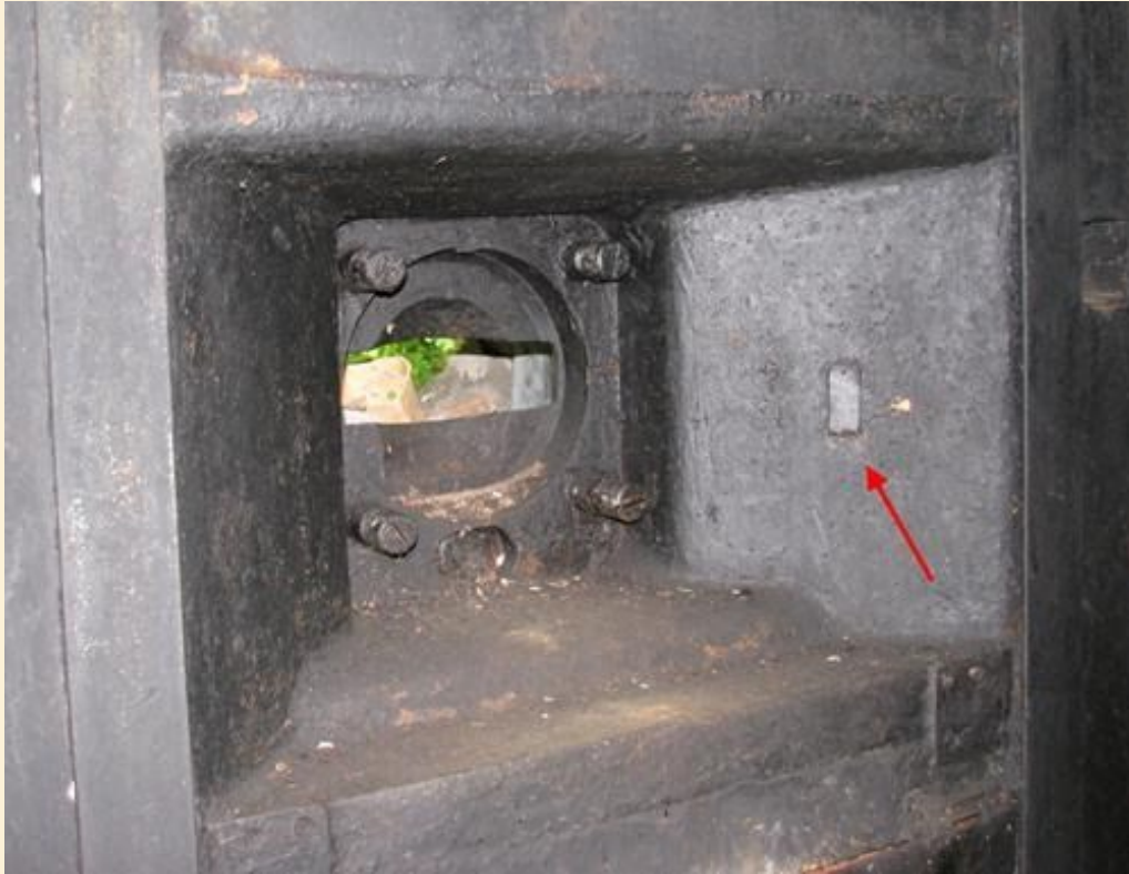
Pancerz NPS-3 ze wskazanym miejscem montażu tabliczki znamionowej (Zasod №92). Rok 1940. Fot. K.Jankus
