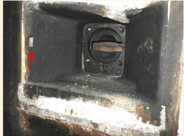
Pancerz NPS-3 z Debalcewa ze wskazanym miejscem montażu tabliczki znamionowej.
