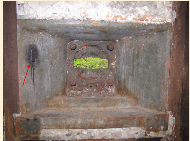
Pancerz NPS-3 ze wskazanym miejscem montażu tabliczki znamionowej (Zawod №92).
