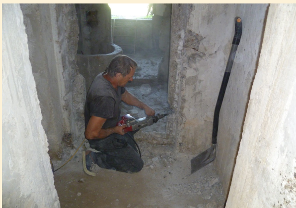
Prace wyburzeniowe we wnętrzu schronu. Fot. J. Kulak
