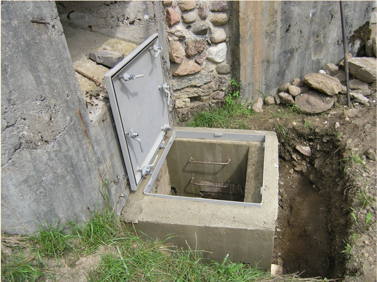
Zabezpieczenie wyjścia ewakuacyjnego.
