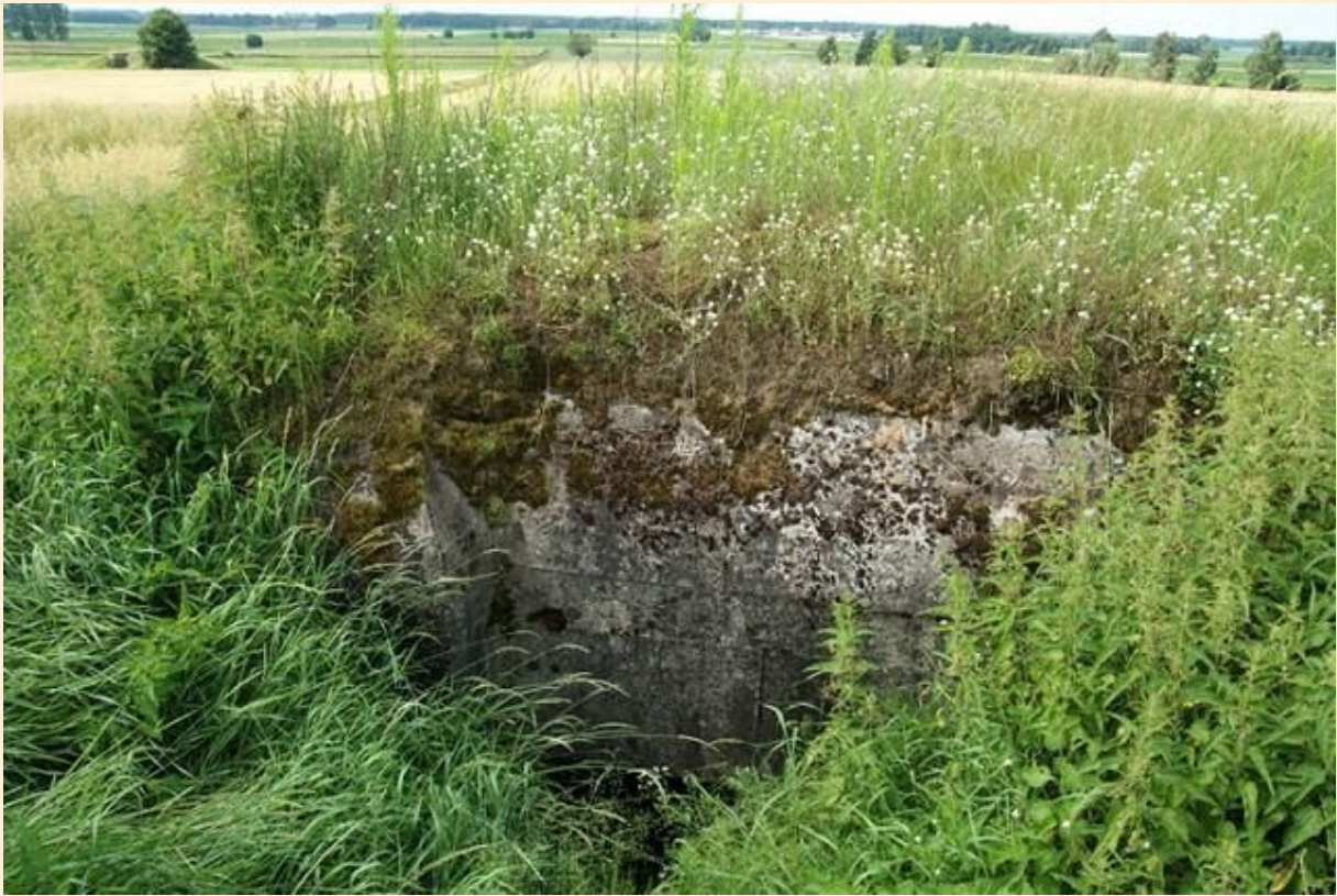
Schron obserwacyjny 64-JK-02, widok od strony wejścia. Stan z 2009 roku. Fot. P. Tymiński
