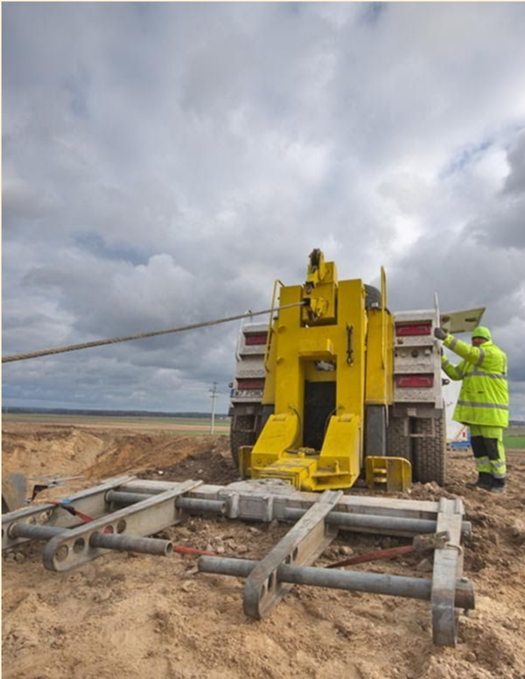
Holownik drogowy w położeniu roboczym, dodatkowo ustabilizowany własnym podnośnikiem. Fot. P. Tymiński
