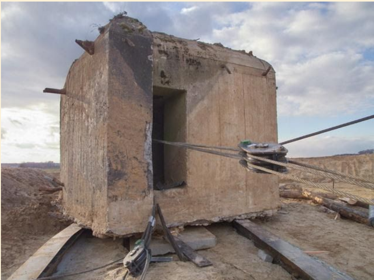
Ruszy czy nie ruszy? Schron obserwacyjny przygotowany do podróży. Fot. P. Tymiński
