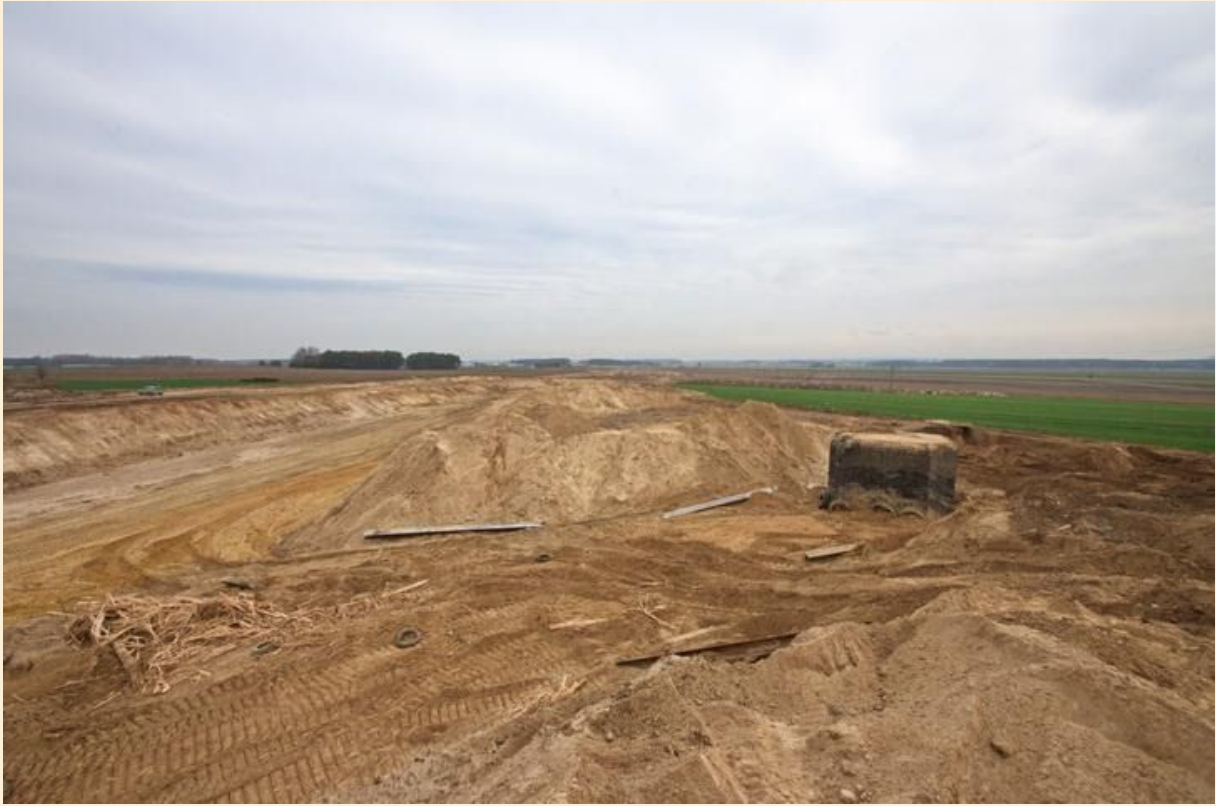
Efekt końcowy – schron obserwacyjny odsunięty od pasa drogi. W wykopie widoczne zdemontowane szyny, po których przesuwano obiekt. Z lewej strony kadru sterta rozłupanych na drzazgi okrąglaków, po których początkowo próbowano przesuwac schron. Fot. P. Tymiński
