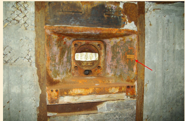
Pancerz NPS-3 ze wskazanym miejscem montażu pełnowymiarowej tabliczki znamionowej „Серп и Молот - Москва”. Fot. P. Tyński
