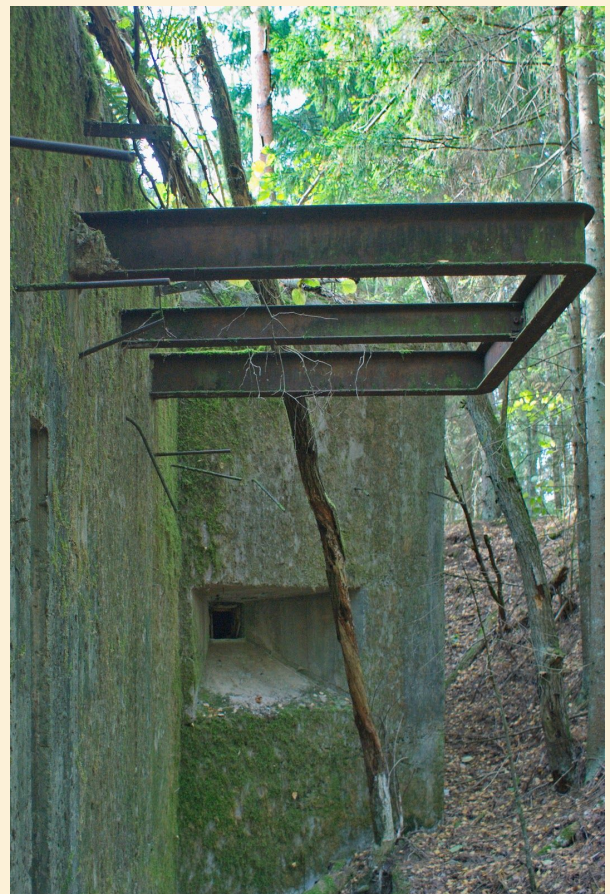
PDOT (48-PA-09) z charakterystycznymi szynami nad wejściem. Na Litwie tego typu elementy miały więcej szczęścia i spotyka się je częściej niż u nas. Fot. K. Jankus.
