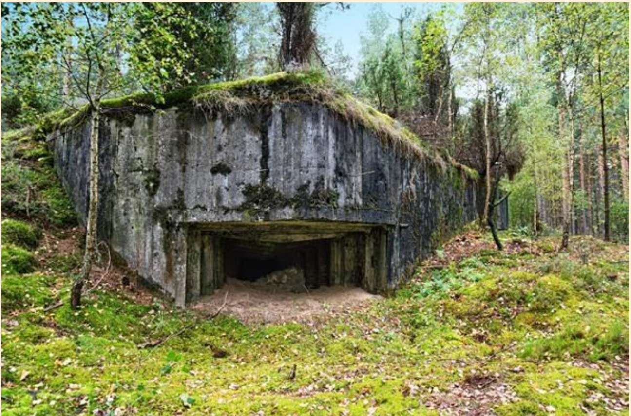
Widok na ambrazurę dla zestawu Ł-17 na schronie typu ADOT (ADOT-1-L). Punkt Oporu Ciemnoszyje, 66 Osowiecki Rejon Umocniony. Fot. P.Tymiński (2012)
