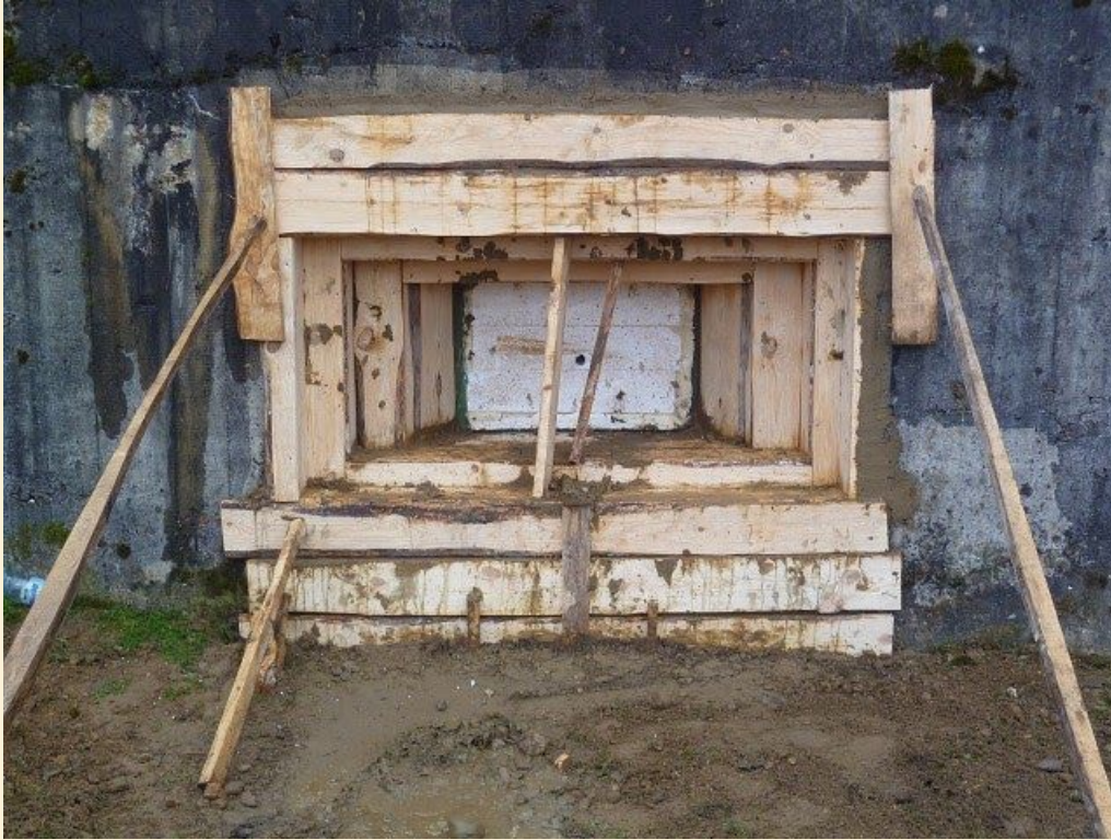
Zabetonowany szalunek pancierza. Fot. J. Kulak
