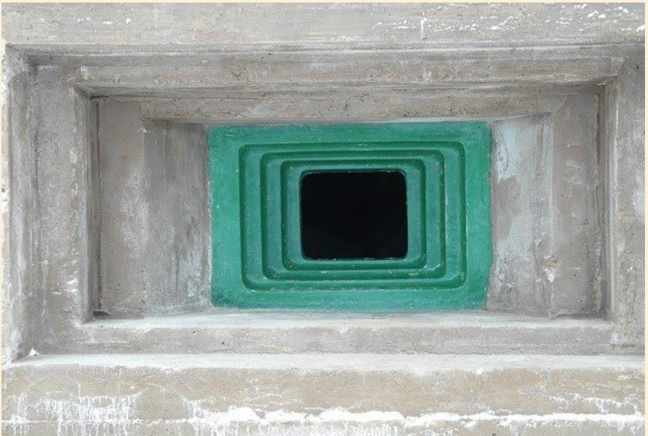
Replika pancerza od strony zewnętrznej – widoczne schodkowanie przeciwwrykoszetowe. Fot. J. Kulak
