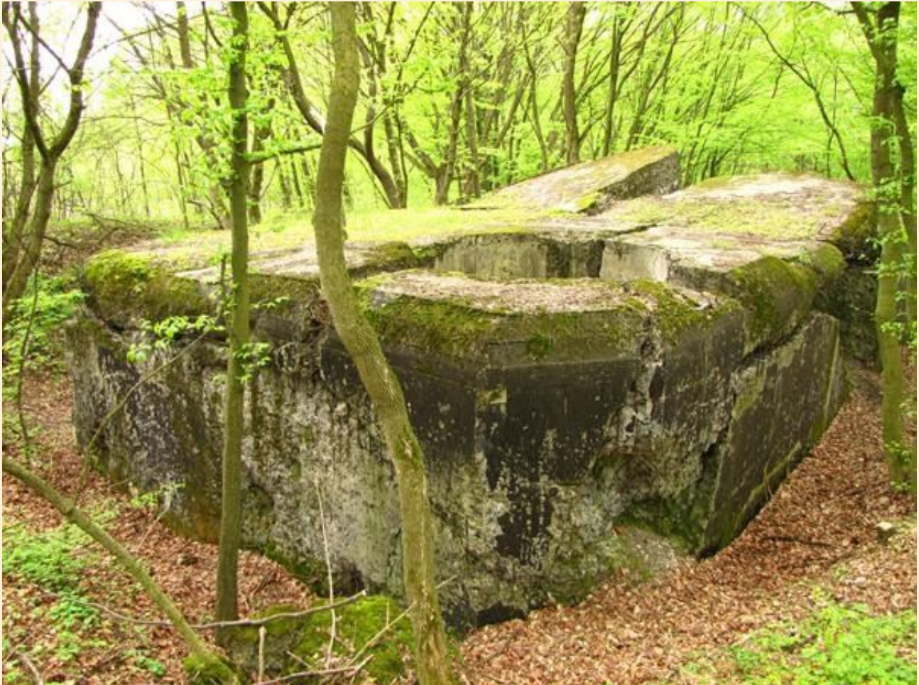
Widok na część tyłową (z otworem technologicznym po wymontowanej kopule pancernej) zniszczonego schronu typu APK (APK-4-P) zbudowanego na terenie Punktu Oporu Krasieczyn, 08 Przemyski Rejon Umocniony. Fot. M. Kozdrój (2014)
