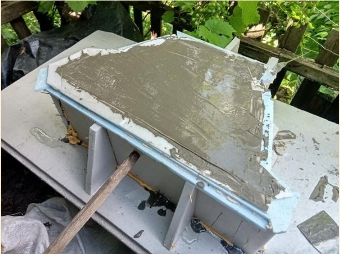
Faza betonowania modelu kaponiery. Fot. O. Kreszczanow
