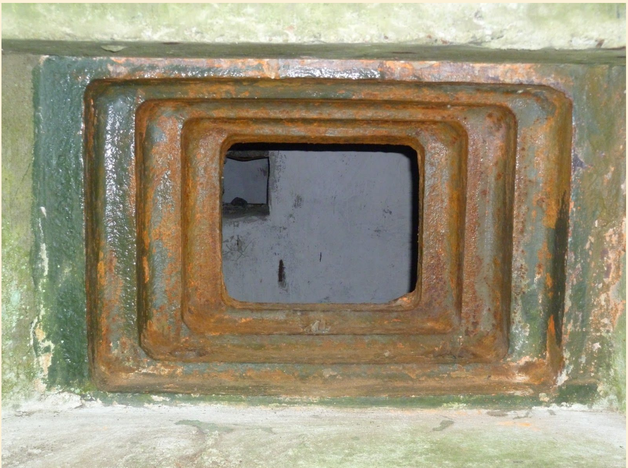
Oryginalnie zamontowany pancerz DOT-4 na którym wykonano formę dla repliki pancerza. Fot. J. Kulak
